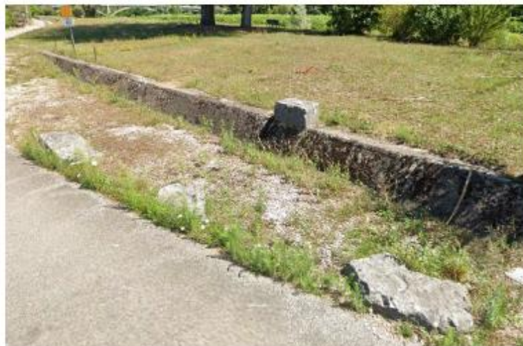
Blocs de pierre situés en bas de la rampe d'accès
