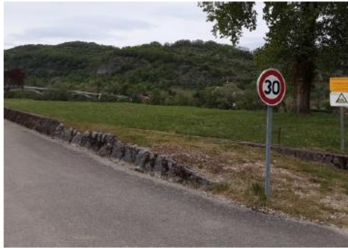
Voie ouverte à la circulation et rampe d'accès à l'ouvrage
